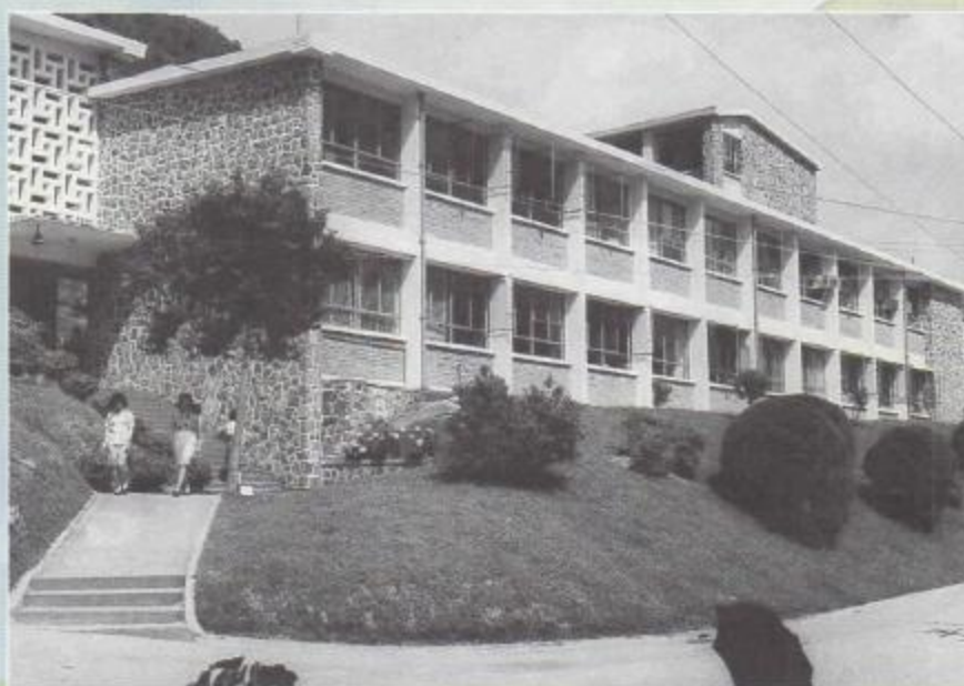
舊教學樓近景
