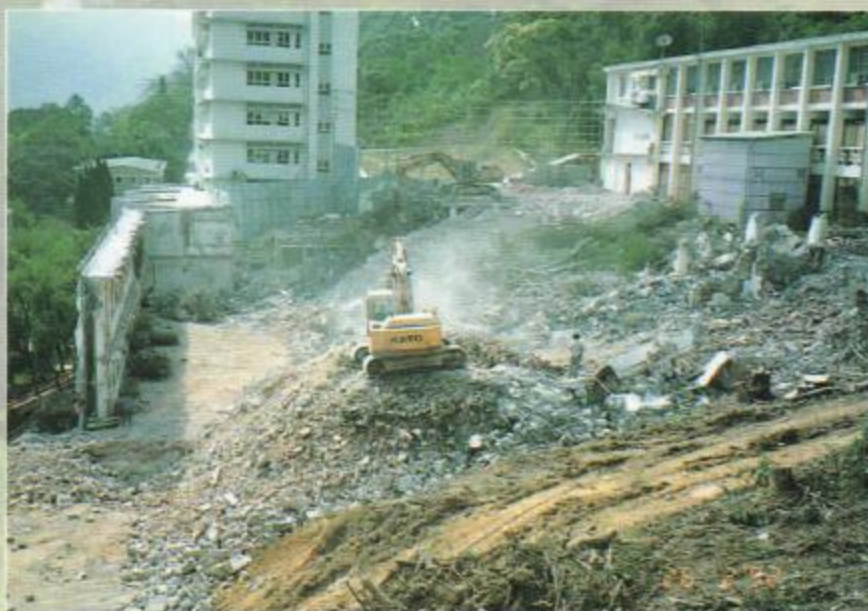
九二年春，推土機所到之處，教學樓夷為平地。
